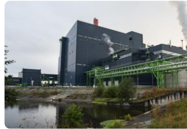
21. sajand Auvere elektrijaam
